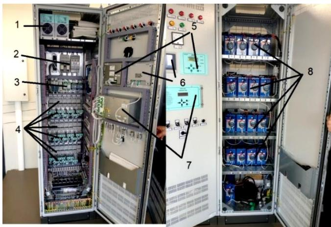
Рис. 1. Шкаф оперативного тока и шкаф аккумуляторных батарей:
