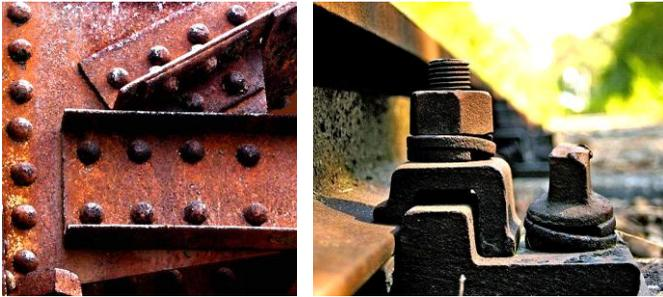
Рис.1. Ржавчина – продукт коррозии железа
