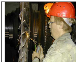
Рис. 1. Формирование покрытия на входных кромках рабочих лопаток 30-й ступени турбины ПТ-80-130 ЛМЗ АО «Кишиневская ТЭЦ-2» (ст. № 1) при положении ротора на козлах ремонтной площадки
