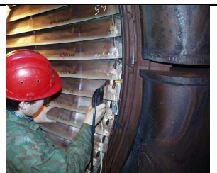
Рис. 3. Формирование покрытия на входную и выходную кромки рабочих лопаток 29-й ступени через конденсатор при текущем ремонте турбины К-300-240 ЛМЗ на Рязанской ГРЭС (ст. № 3) через конденсатор турбины
