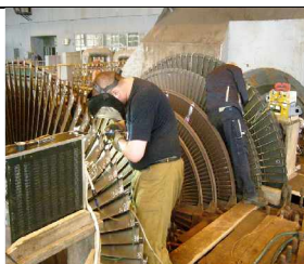
Рис. 2. Формирование покрытия входных кромок рабочих лопаток 34-й и 39-й ступени турбины К-300-240 ЛМЗ ТЭС «Гацко» (ст. № 1) в г. Гацко Республики Сербской. (Ротор находится в подшипниковых опорах при снятой крышке цилиндра)
