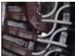
Рис. 2. Ультрафиолетовграмма фрагмента поверхности лобовой части в зоне выхода трубок водяного охлаждения (вид со стороны возбудителя) при 31 кВ (область 24 паза с повышенным уровнем поверхностного загрязнения) ( $N(q) - 1938$  /мин)
