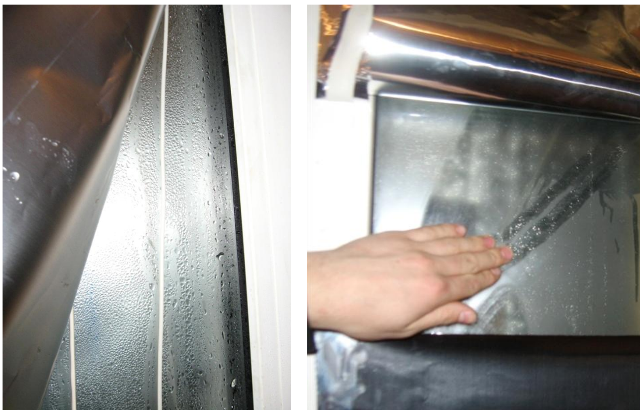
Рисунок 3.15 – Наличие конденсата на поверхности стекла, обращенного в теплое отделение камеры, в случае использования теплоотражающих экранов со стороны ТО
