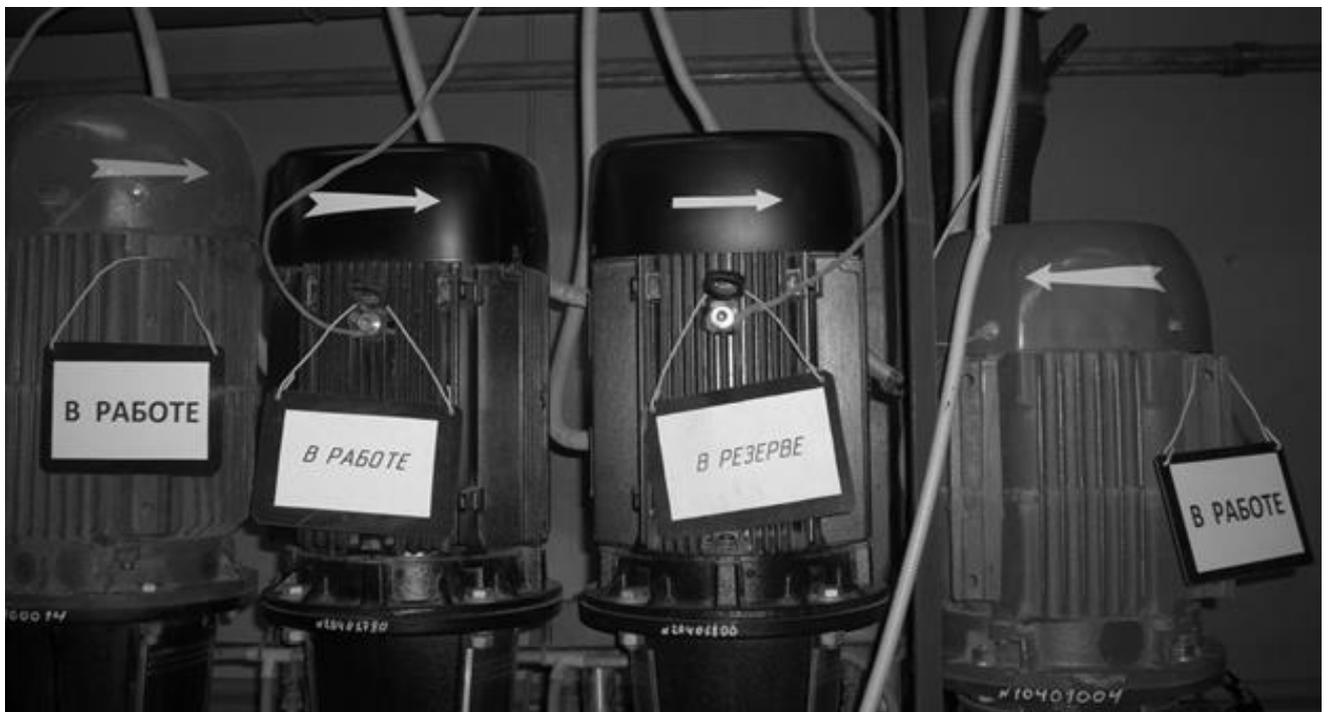
Рис. 4.46. Взаимное расположение АД сетевых насосов котельной
