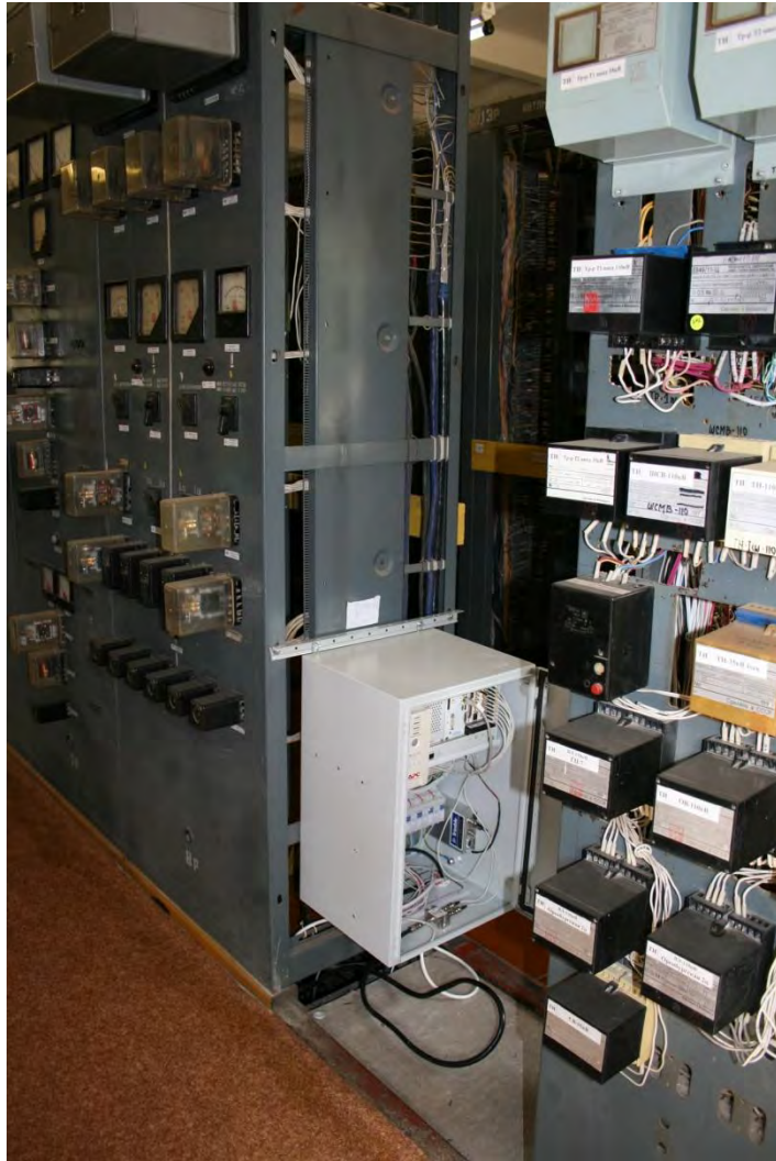
Рис. 3.3. ПС Пугачевская. Регистратор № 1 в панели № 9р ОПУ (а) и регистратор № 3 на площадке обслуживания масляного выключателя МКП-110 в ОРУ 110 кВ (б)
