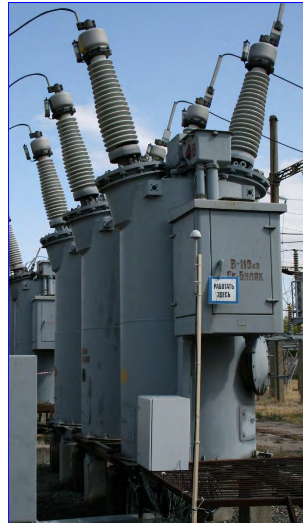
Рис. 3.3. ПС Пугачевская. Регистратор № 1 в панели № 9р ОПУ (а) и регистратор № 3 на площадке обслуживания масляного выключателя МКП-110 в ОРУ 110 кВ (б)
