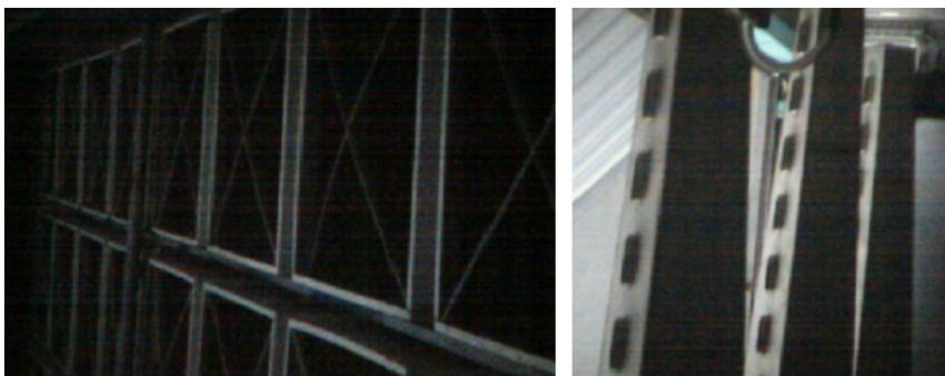
Рис. 8. Вид на фильтры КВОУ (а) и на раздающие сопла горячего воздуха (б), поступающего из 10-й ступени компрессора
